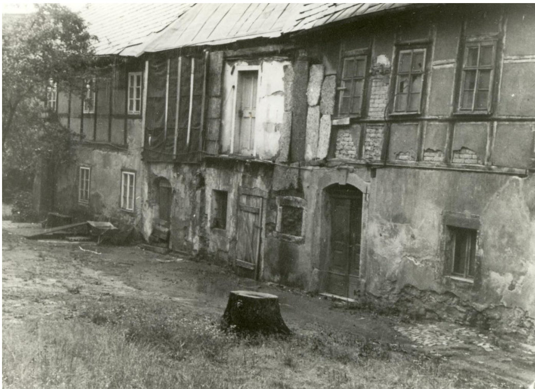
Nach Abtragung des mittleren Anbaus 1972
